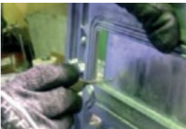
Za brušenje vara na metalnim pločama
